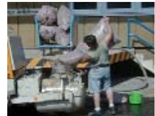
1 Sack (200 L) mit 10-12 Liter Wasser (je nach Produkt) in Estrichpumpe zu einer homogenen Dämmung mischen (ca. 2 Min. Mischzeit).
