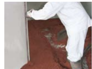
Lehren (Faschen) schütten, verdichten und auf Niveau abziehen.
