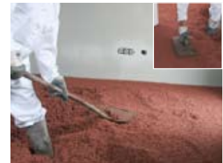
Die Anschlusskanten an der Mauer nacharbeiten und aufgetragene Fläche verdichten.
