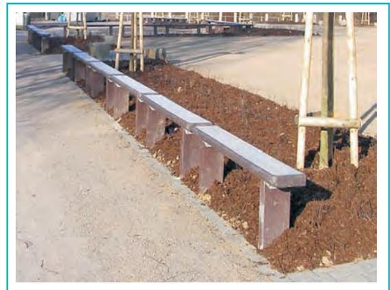
Bankbohlen Typ Kompakt mit einem maximalen Stützabstand von 130 cm montieren.
