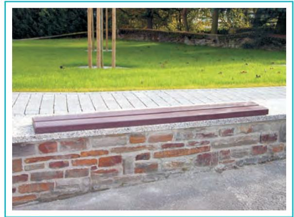
Bankbohlen Typ Premium mit einem maximalen Stützabstand von 145 cm montieren.
