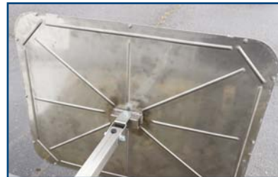
Rückwand und Halterung aus Edelstahl.
