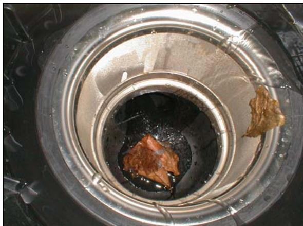
Abbildung 22: (links) WISY Wirbel-Fein-Filter mit Verschmutzung (Laub)
