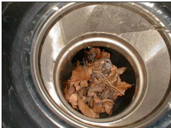
Abbildung 23: (rechts) WISY Wirbel-Fein-Filter mit Verschmutzung (Laub)
