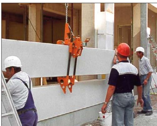
Flachgreifer FG/U mit Unterfangung für die sichere Montage von Wandplatten, auch außerhalb des bodennahen Bereiches.
