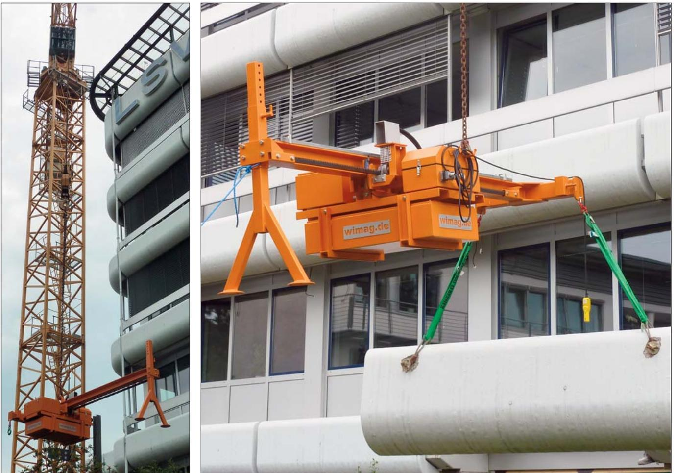
WIMAG Ausgleichstraverse AGT mit hydraulisch verfahrbarem Gegengewicht bei der Demontage von Betonelementen, da diese wegen des Dachüberstandes nicht direkt angeschlagen werden können.
