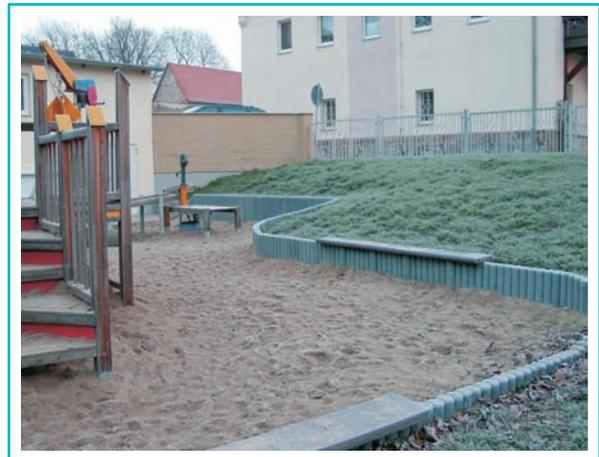
Beachten Sie beim Verbau von Recyclingprofilen temperaturabhängige Längenschwankungen (bis +/- 1,5 %).
