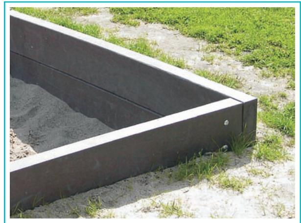
Bei liegendem Verbau von Recyclingprofilen muss ein Verlegeabstand eingehalten werden, um die temperaturabhängigen Längenschwankungen der Profile (bis +/- 1,5 %) abzufangen. Ansonsten können sich die Profile bei Ausdehnung gegenseitig verschieben. Auch bei der Fixierung auf ein Fundament ist dieser Effekt zu berücksichtigen (z.B. Verschraubung mit Langlöchern). Die Spalten können mit dauerelastischen Dichtstreifen oder Moosgummi verschlossen werden.
