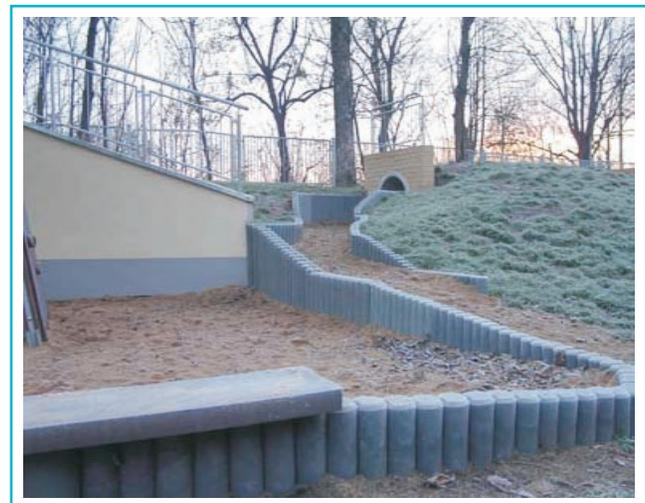
hanit® Produkte bestehen aus hochwertig aufbereiteten Sekundärkunststoffen.
