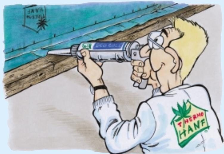
... an Wand- und Bodenstellen sowie bei Holzanschlüssen und -durchdringungen befestigt Theo die Dampfbremse mit EcoColl – klebt klasse.
