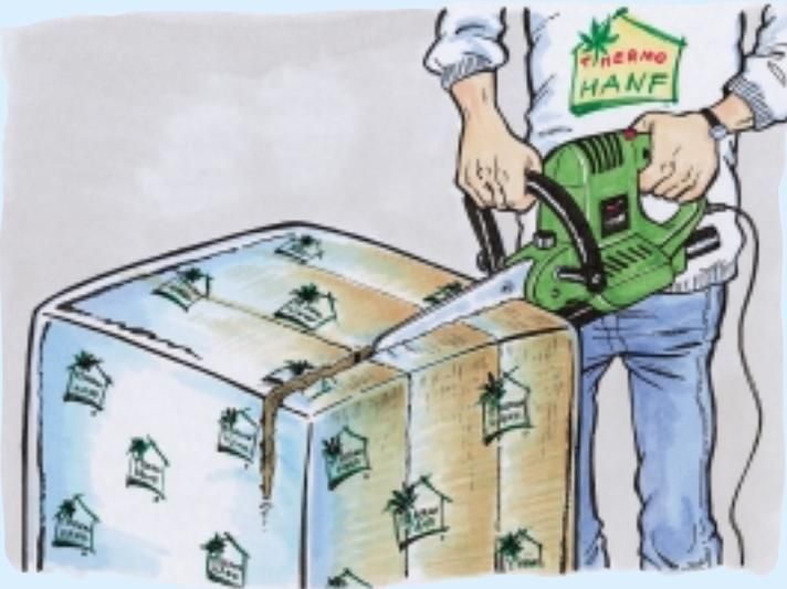
Den Aligator nimmt er dann gleich für den Zuschnitt von einem ganzen Mattenpaket. Matten in der Folie bündig senkrecht stellen – sauber schneiden...
