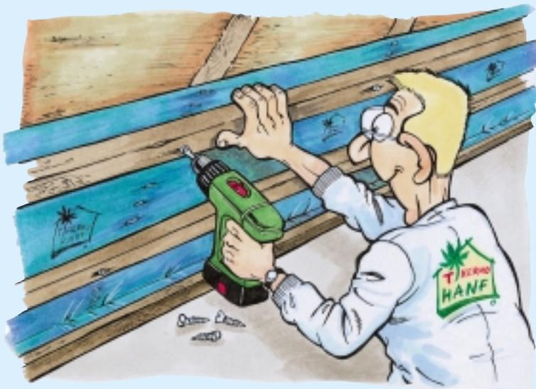
Endspurt im Dachgeschoß – das Einbringen der Installationsebene. Zuerst die Querlattung maßgenau anschrauben...
