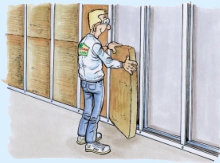
Dann kann er wieder die passgenauen Dämmplatten ansetzen, in die Metallständer einführen und andrücken.
