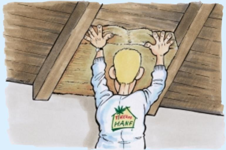
... dann etwas stauchen, damit sich keine Wärmebrücken bilden. Das klappt vorzüglich.
