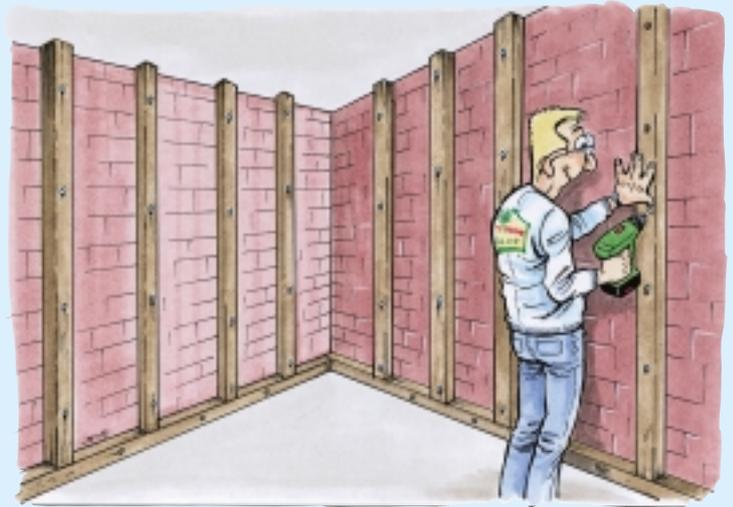
Für die Gefache an der Außenwand werden Holzständer verwendet und mit gleichen Abständen befestigt.
