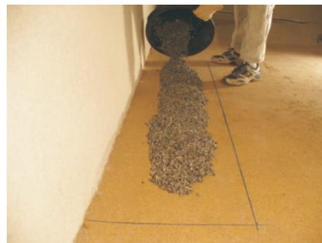
**7** Verteilen Sie das Gemisch umgehend innerhalb dieser Fläche (1m<sup>2</sup>) gleichmäßig und flächendeckend mit dem Distanzraker. Somit wird der Verbrauch und die richtige Schichtstärke gewährleistet. Achten Sie darauf, dass der Distanzraker möglichst senkrecht und langsam geführt wird, um eine gleichmäßige Schichtstärke zu erzielen.
