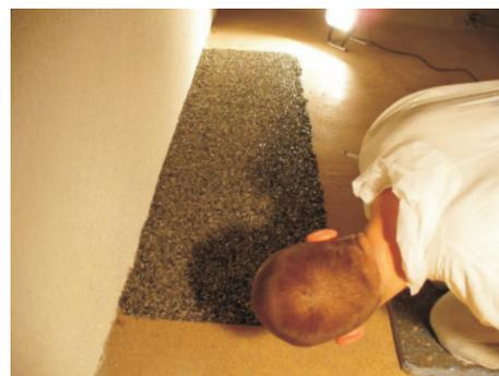
**10** Wenn mit starker Belastung des Bodens zu rechnen ist, empfehlen wir eine Kopfversiegelung. Nach Aushärtung der Fläche (ca. 12 h) wird der RAVELLO Steinteppich mit einer kleinen und weichen Versiegelungsrolle systematisch abgerollt. Dieser Arbeitsgang dient der mechanischen Verfestigung der Oberfläche.
