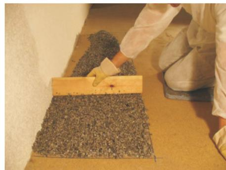
**8** Nun können Sie die Fläche mit der Kelle in wenigen Zügen verdichten und glätten. Achten Sie dabei auf gleichmäßigen Druck und halten Sie das Werkzeug nur leicht angekantet, so dass es fast flach aufliegt und geschmeidig, aber unter Druck, über die Kornspitzen gleitet und die Steinchen gut verpresst.
