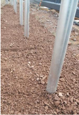
Pfosten einbetonieren, Untergrund vorbereiten
