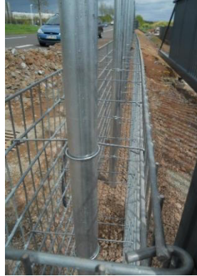
Fixierhaken einhängen, Front-, Rückwand und Seitengitter zusammen- fügen
